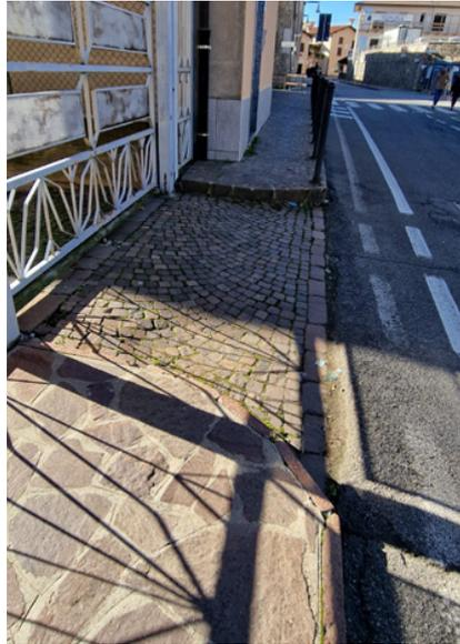
Descrizione prestazionale possibile intervento: Rifacimento del marciapiede o percorso pedonale esistente previa demolizione della pavimentazione compreso il sottofondo, allo scopo di creare un'area raso strada in corrispondenza del passo carraio, realizzando una doppia rampa longitudinale al senso di percorrenza del marciapiede, laddove possibile di pendenza non superiore al 5%.
